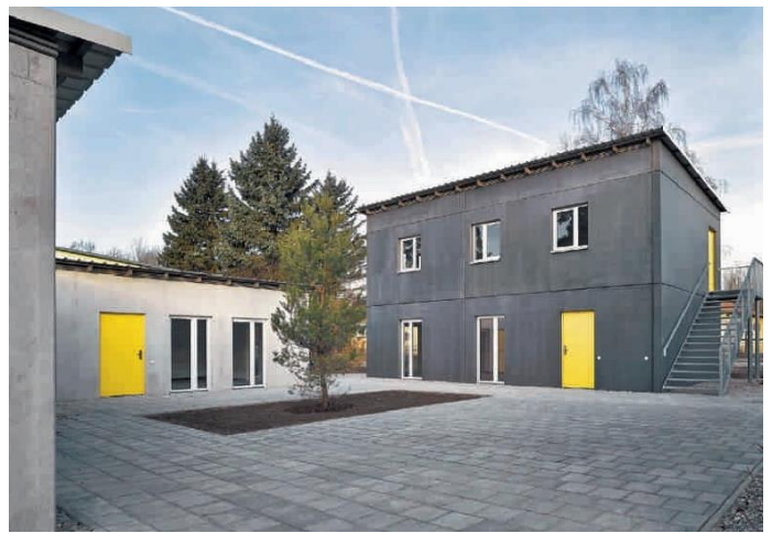
Abbildung 24: Fotos Wohnhaus - Wohnanlage für Obdachlose in Ingolstadt 246
