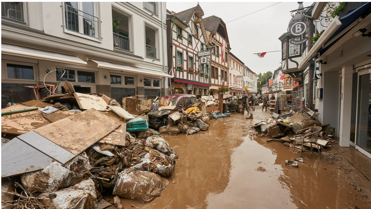
Abb.26: Hochwasserschäden in Bad Neuenahr-Ahrweiler 2021
