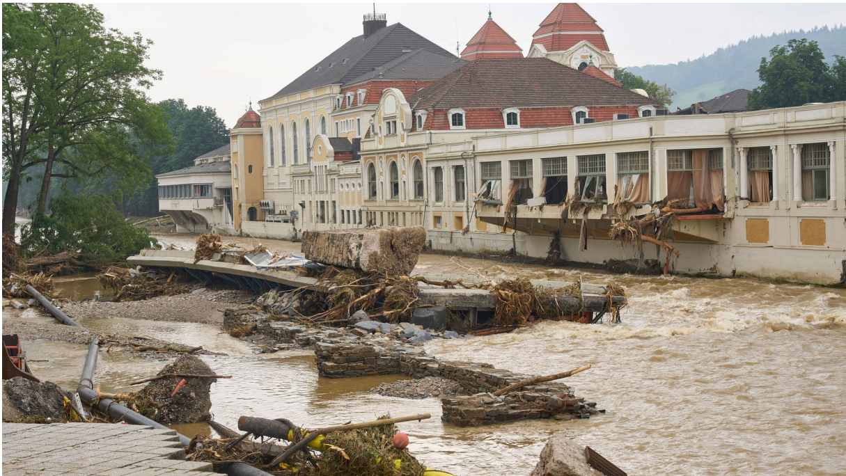
Abb.27: Hochwasserschäden in Bad Neuenahr-Ahrweiler 2021
