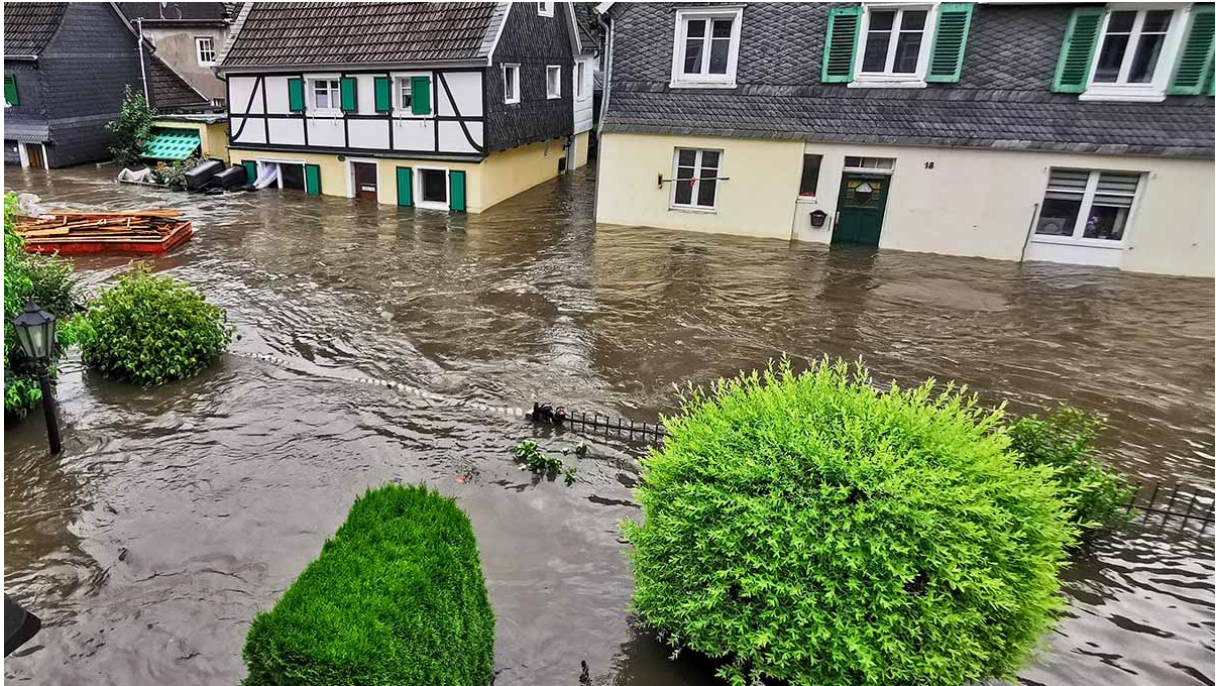
Abb.33: Folgen des Hochwassers in Wuppertal Beyenburg 2021
