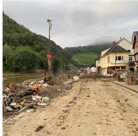
Abb.22: Hochwasserschäden in Mayschoß
