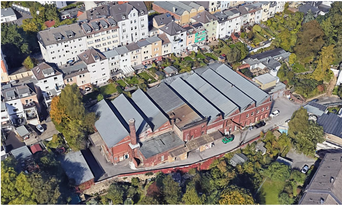
Abbildung 11: Fabrikanlage in der Germanenstraße (Google Earth, 2023).
