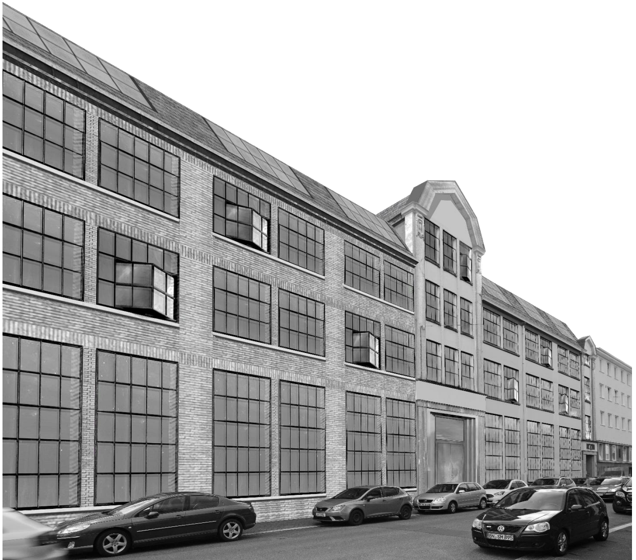
Abbildung 16: Die Ansicht zur Wittensteinstraße zeichnet sich wie die Rückfassade durch ein einheitliches Gesamtbild aus Bestand und Neubau aus. Die Wirkung eines Fabrikgebäudes wird durch den Einsatz von Backstein für die Fassade des Neubaus verstärkt (Eigene Darstellung).
